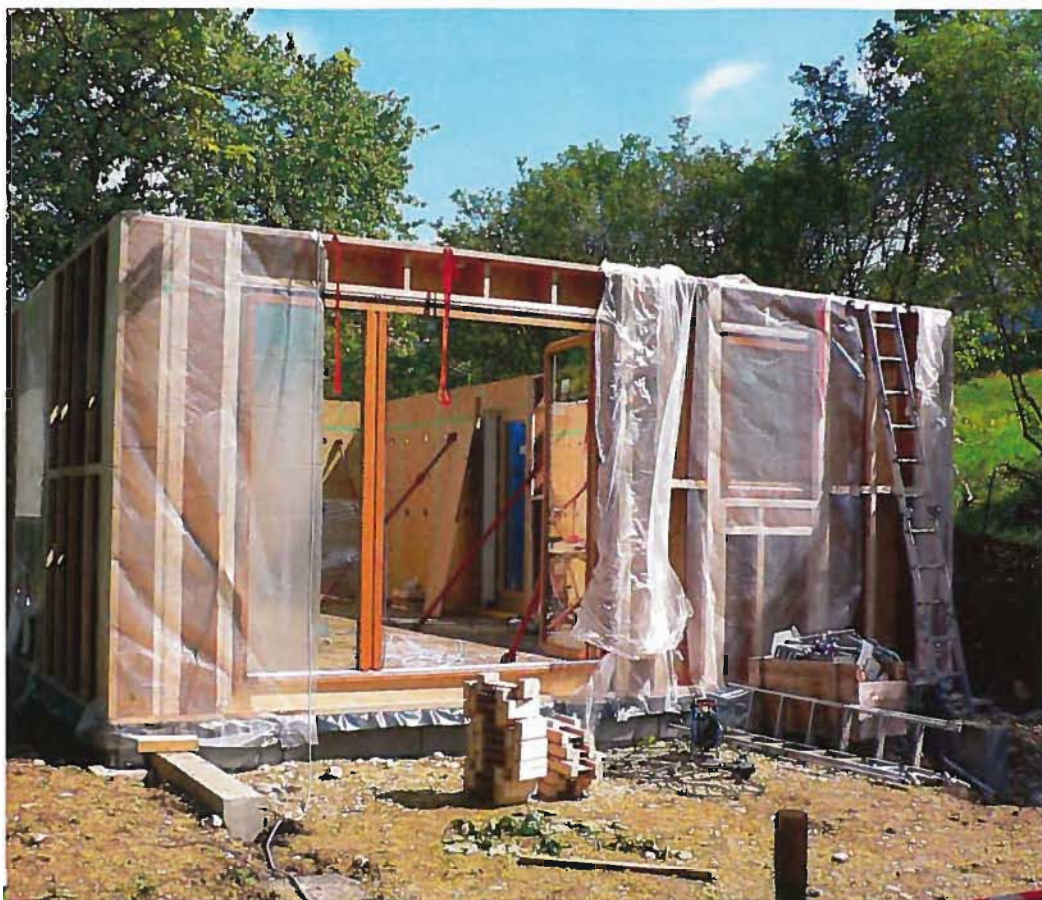
Les murs à ossature de 30 cm d'épaisseur ont été fabriqués et montés en atelier par Etamines et livrés sur site avec leurs menuiseries. Les trous que l'on aperçoit sont les ouvertures ménagées pour l'insufflation de ouate de cellulose sur site. Ils sont ensuite bouchés et étanchéifiés.
