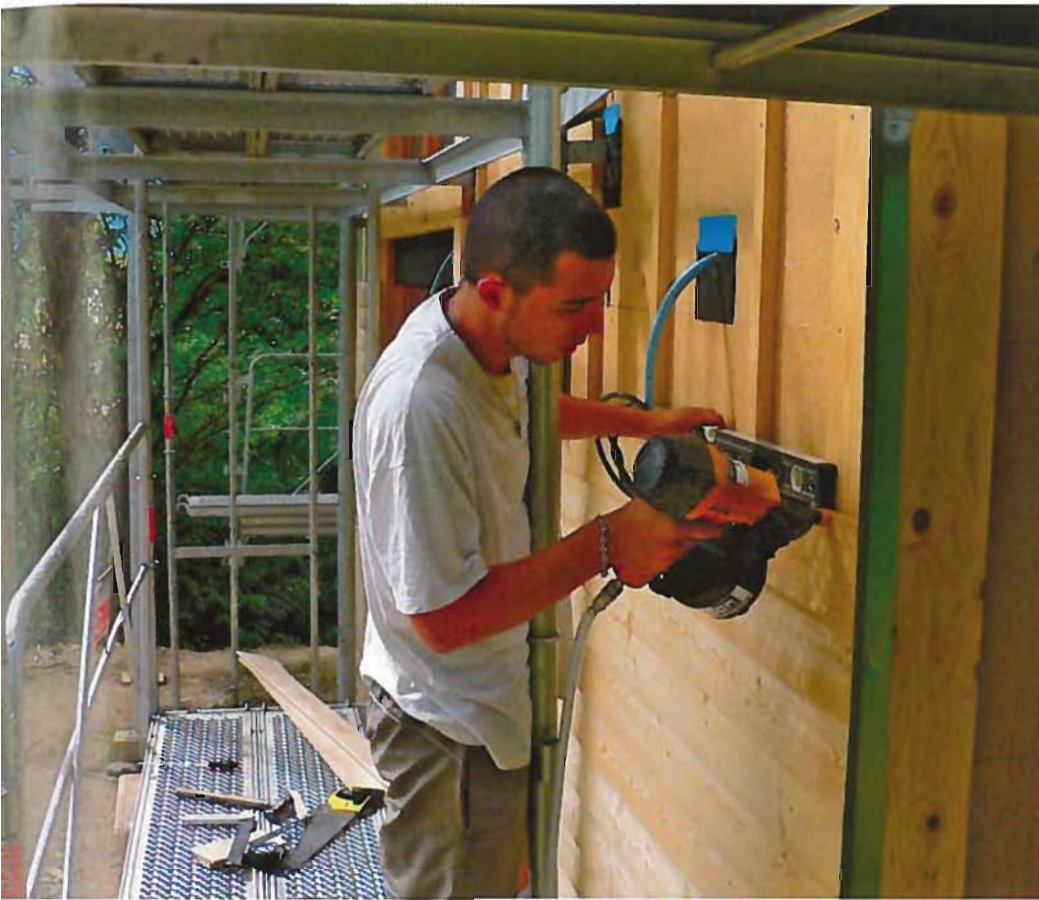
Une fois les murs doublés par l'extérieur avec 6 cm de fibre de bois rigide, ils sont habillés d'un bardage.
